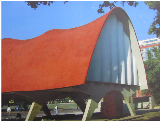
Figura 7. Esta edificación, originalmente conocida como el Pabellón de Rayos Cósmicos, actualmente funciona como ludoteca.
